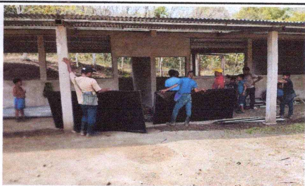
Foto 3: Colocacion de dos puertas de metal de la construccion del proyecto de remozamiento de dos aulas.
