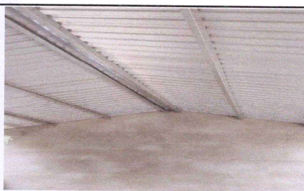
Foto 4: Vista interior del techo de la construccion del proyecto de remozamiento de dos aulas.
